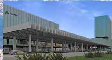
Nouvelle Gare TGV Sagrera
