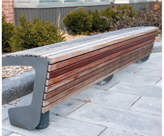
Un banc installé lors de la revitalisation du centre-ville en processus de décoloration.
