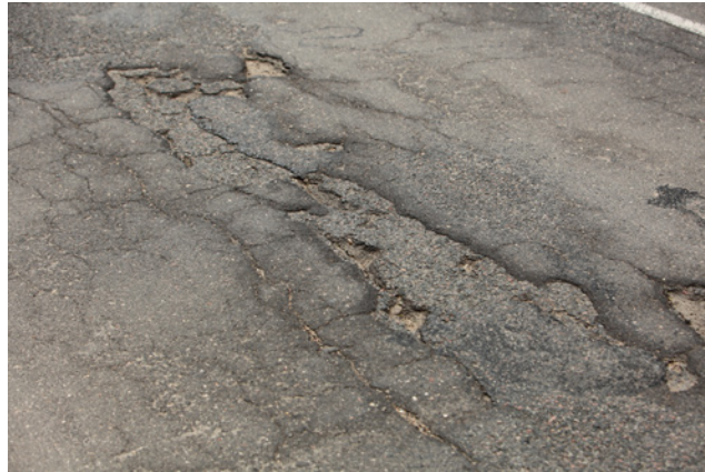
Un exemple de faïençage, qui ne peut pas être colmaté par temps froid.
