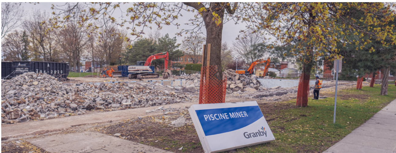
Le site de l'ancienne piscine Miner après la démolition, au printemps 2021.
